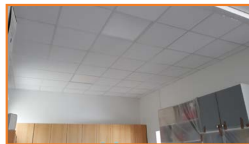
Avant / Après la pose de faux plafond
