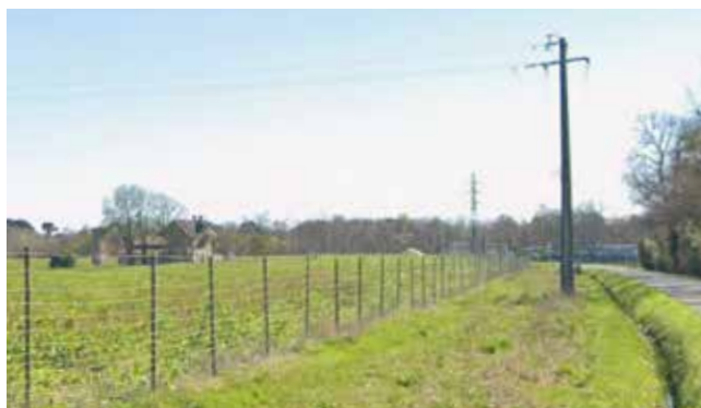
Avenue des Bons Enfants, avant la dépose des poteaux.
