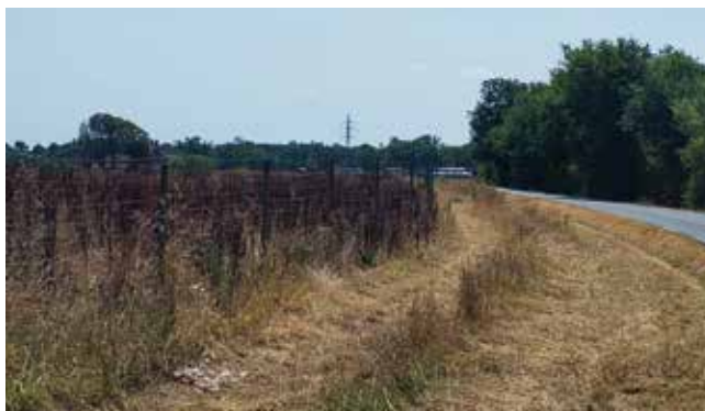
Avenue des Bons Enfants, après la dépose des poteaux.
