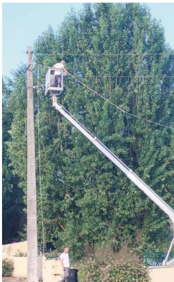
Dépose des câbles électriques avant enlèvement du poteau en béton.
