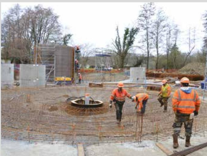
Station d'épuration, le fond du bassin clarificateur en cours d'armaturage et bientôt prêt à être coulé.
