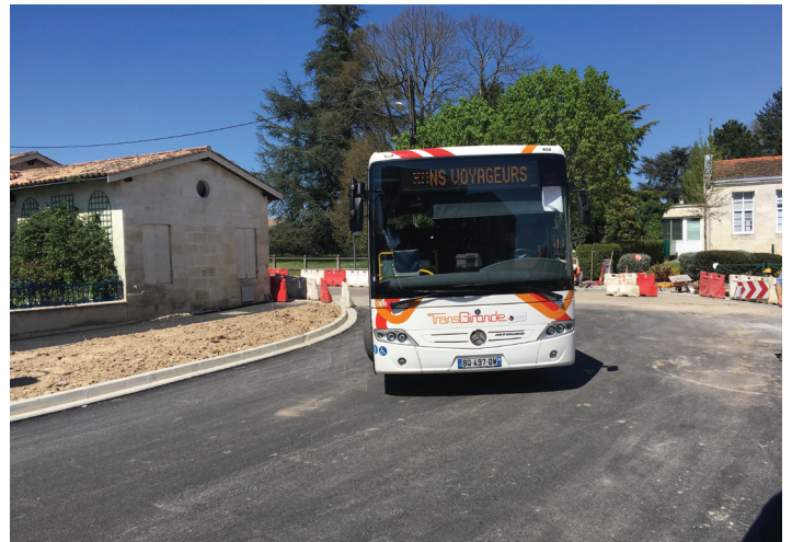
Mardi 17 avril, essai de circulation sur la voie nouvelle avec les bus TransGironde
